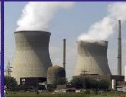
Nhà máy điện hạt nhân
