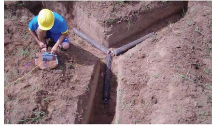
Hình 2. Hình ảnh nối đất 3 tia có GEM
