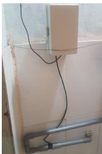
Hình 17. Lắp đặt phần cứng vào thực tế
